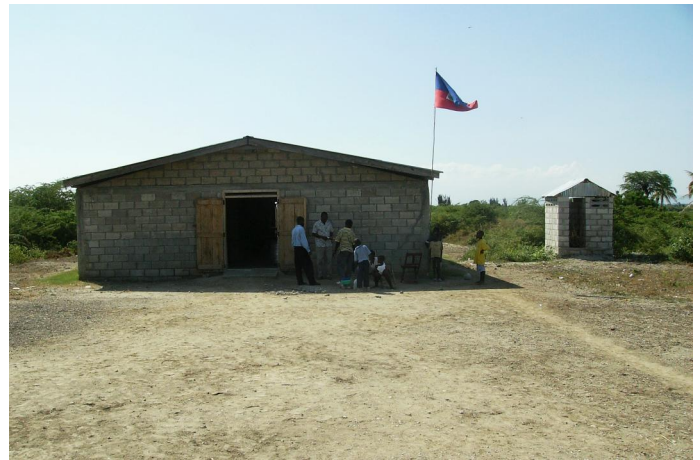
École de Grand Islet - Latrines en construction
