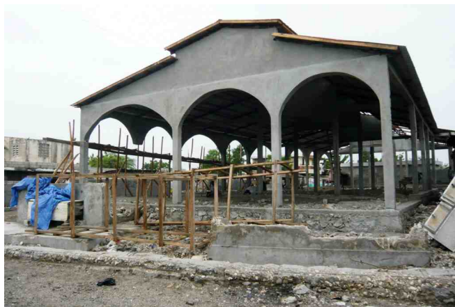
Le nouveau marché en construction
