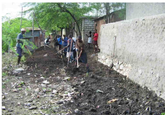
Chantier AFHAD d'entretien des drains coordonné par la Mairie de Desdunes
