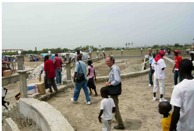
La Place Publique en construction
